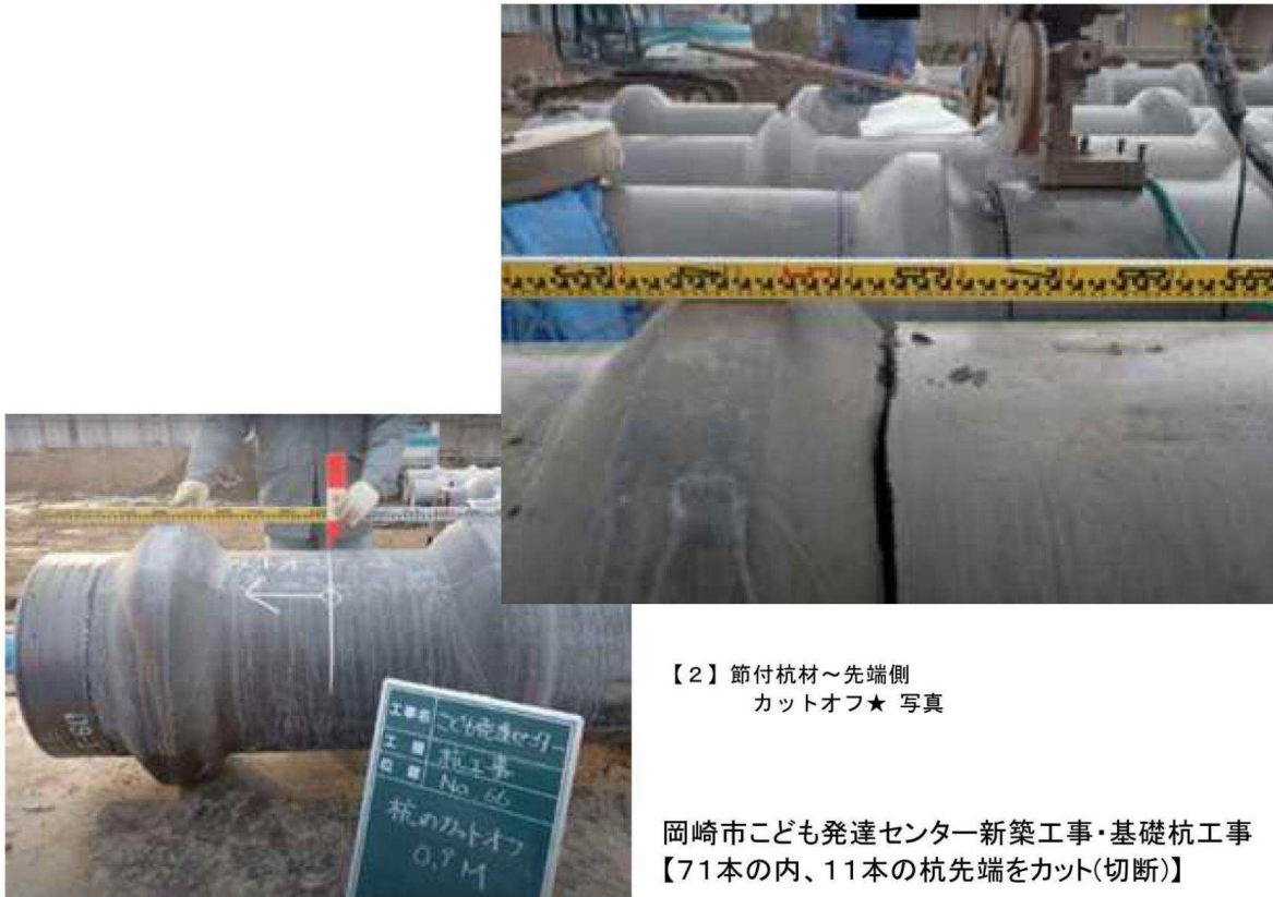
【3】節付杭先端側カットオフ 施工★写真～通報者提供～
