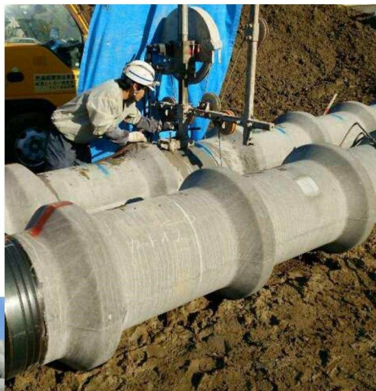
【3】節付杭先端側カットオフ 施工★写真～通報者提供～
